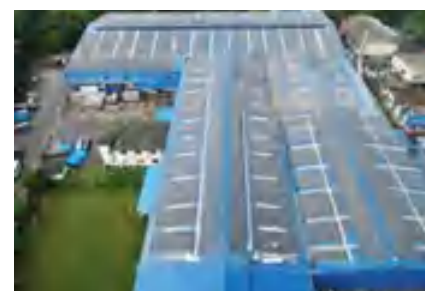
Mega Roof Solar Project-Swissteck Aluminium Ltd
